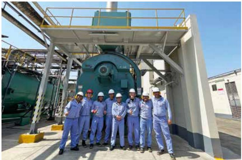
internos rodeados de agua. Esta agua se calienta mediante la combustión de gas natural que se usa al 100 % en todo el proceso, generando vapor que es utilizado para la producción del 75% de los productos de Ajinomoto del Perú, incluyendo sazónadores, fideos y sillao. Actualmente, tres de las cuatro plantas de producción dependen del vapor generado por sus calderas, que operan al 100% de su capacidad.
